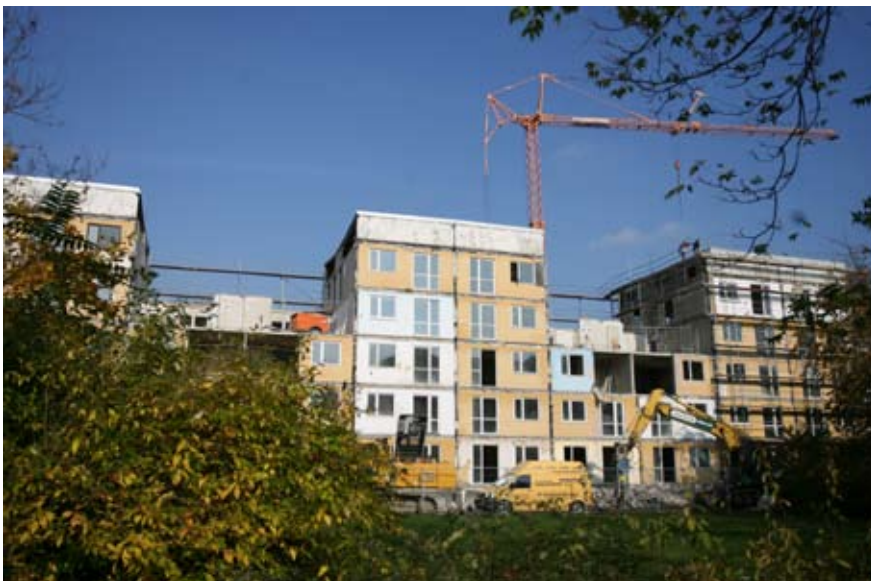
Das Wohngebäude am Oleanderweg 21–45 zum Zeitpunkt der Rückbaumaßnahme im Spätsommer 2008.
