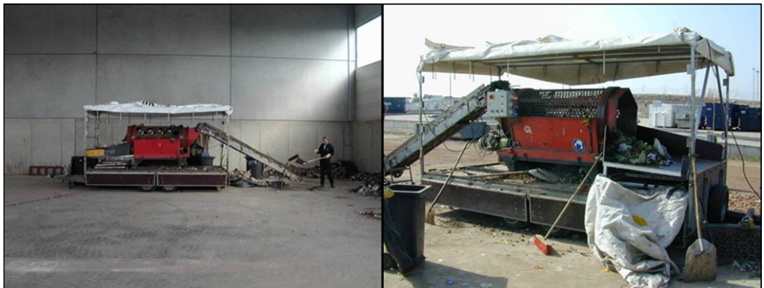
Bild 2-1: Eingesetztes maschinelles Siebaggregat
